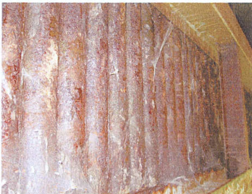
Foto č.7 – Pohled na spodní líc mostovky – zkorodované ocelové nosníky a ocelové trubky
