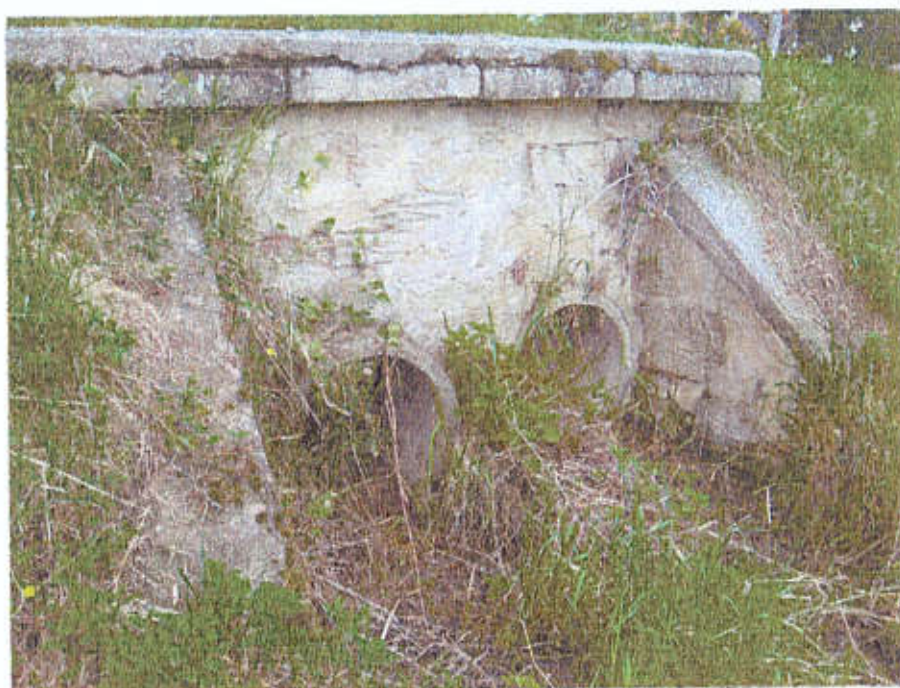
Foto č.5 – Pohled na vyústění propustku na pravé straně mostu
