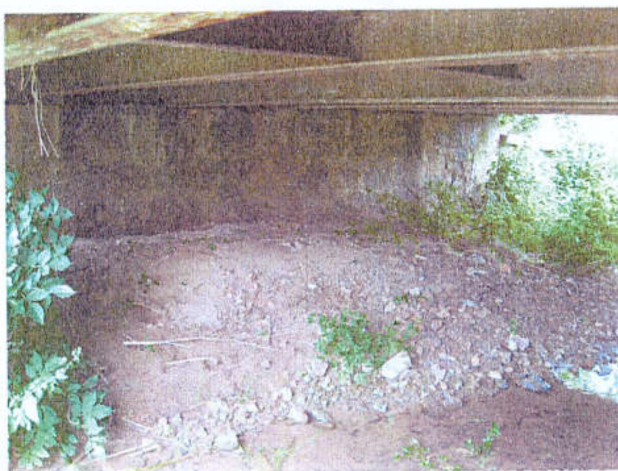
Foto č.6 – Pohled na opěru 01 – zřetelná koroze spodní stavby, zanesené koryto
